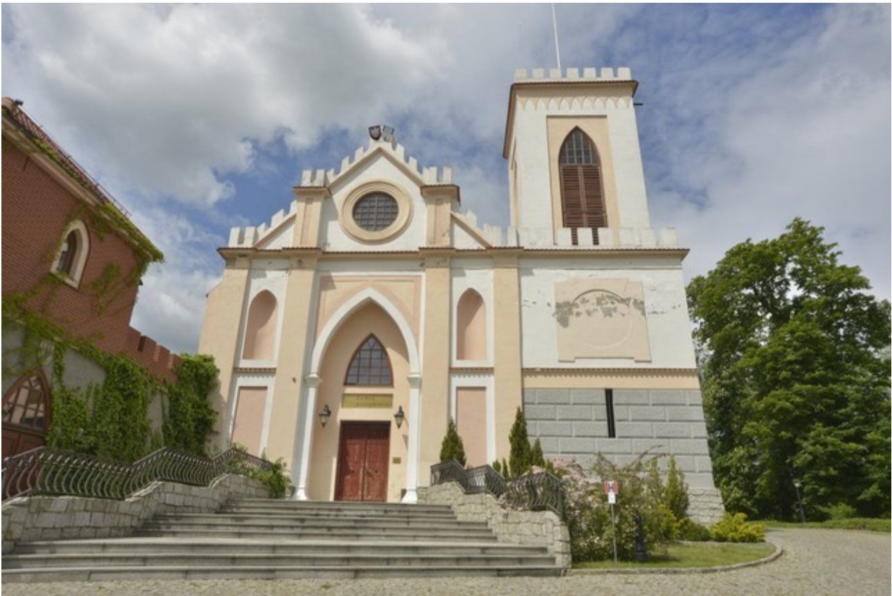
Fot.1 Widok ogólny budynku od strony frontowej.
