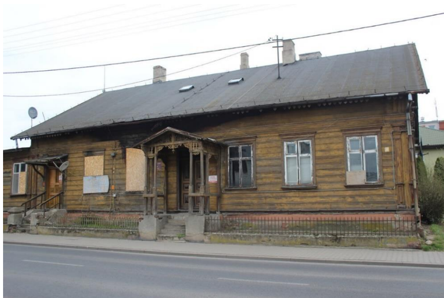
Fotografia 15. Budynek przy ul. Kościuszki 5
