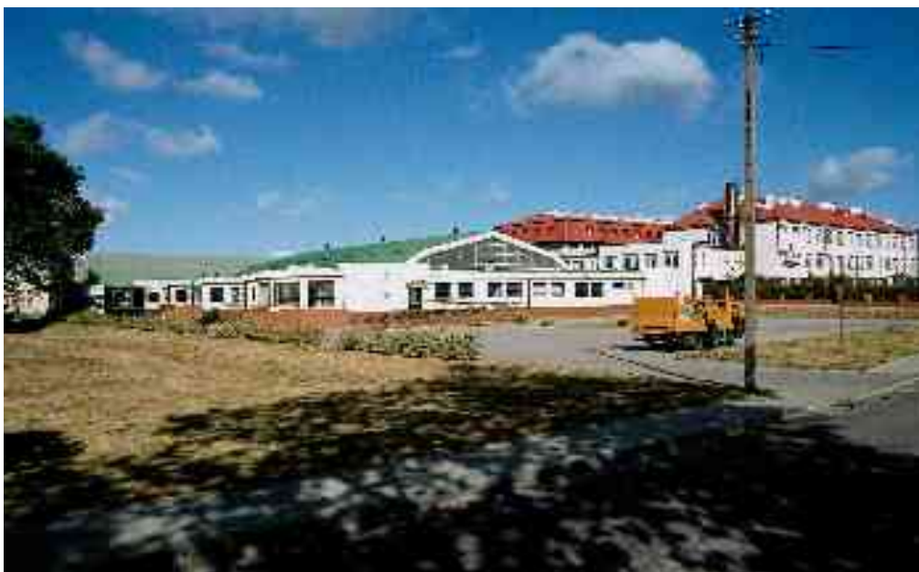
Kompleks sportowy przy ul. Kutnowskiej.
