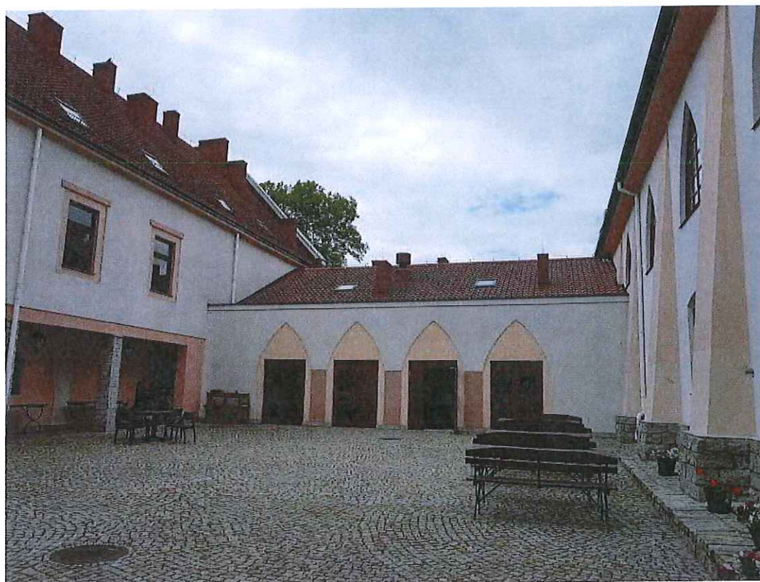
Elewacja zachodnia dziedzińca.
