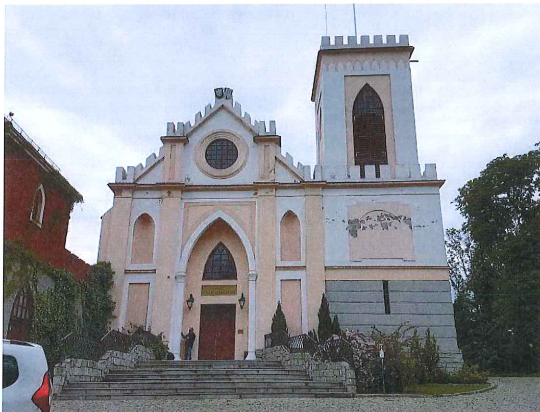
Elewacja frontowa (zachodnia).
