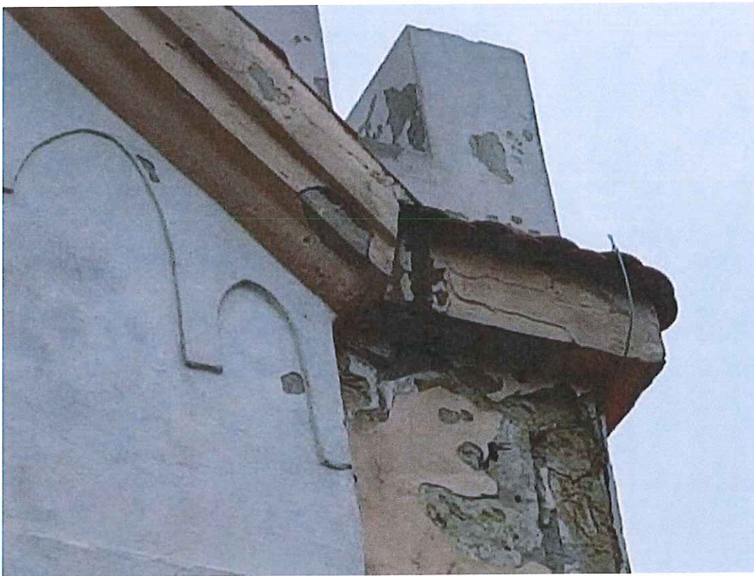
Gzys w narożniku południowo-zachodnim budynku kaplicy.
