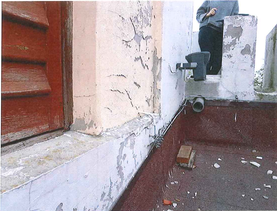
Połączenie dachu kaplicy i południowej ściany baszty.
