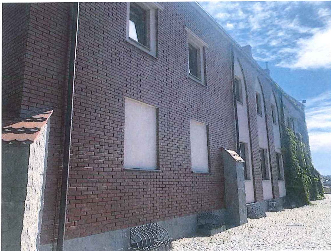
Elewacja południowa współczesnej zabudowy wzgórze.
