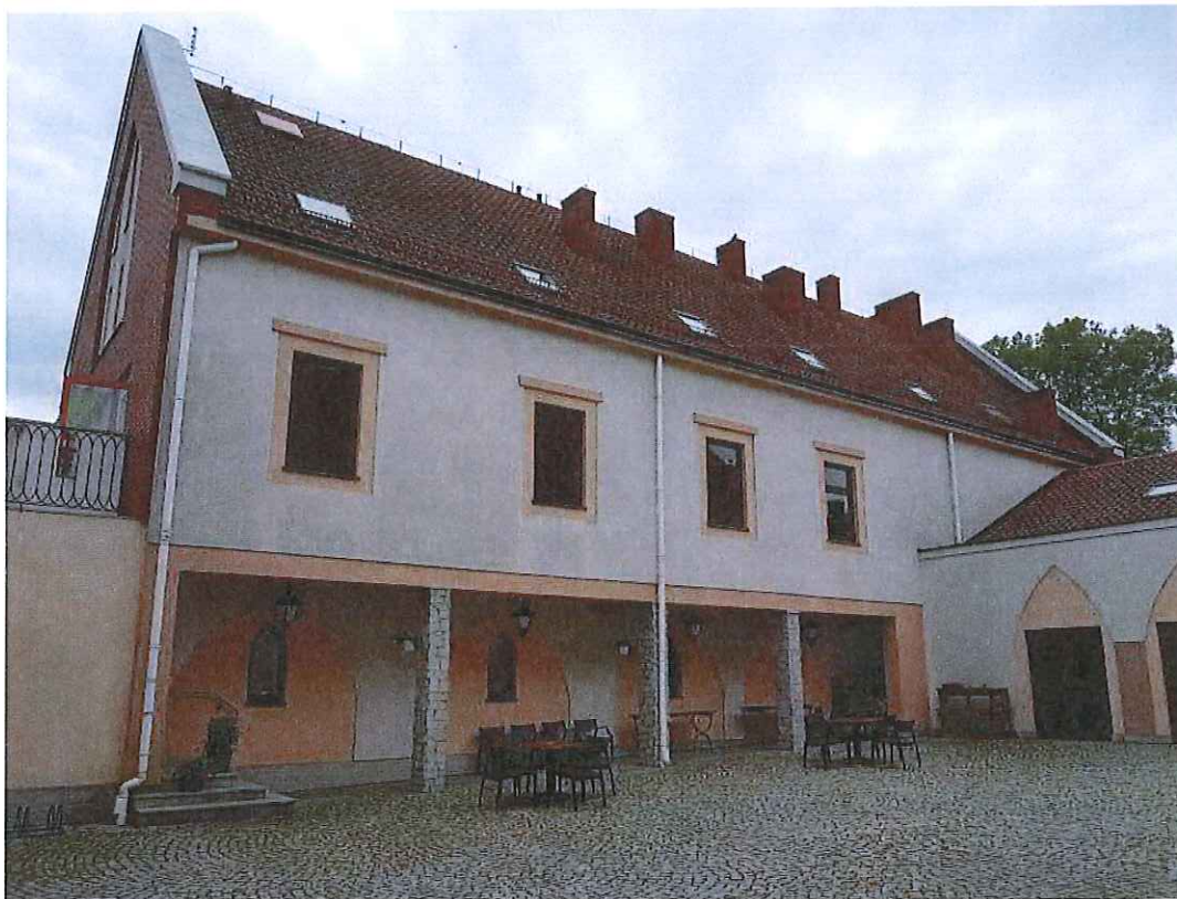
Elewacja południowa dziedzińca.
