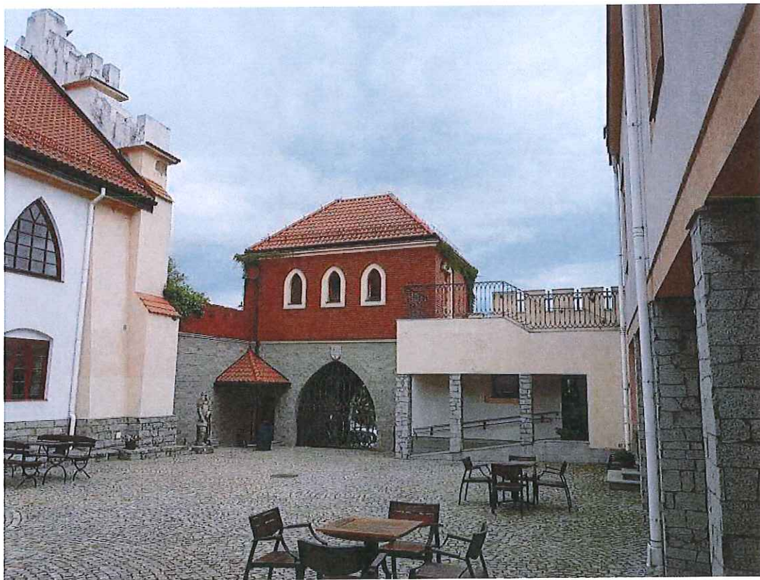
Elewacja zachodnia dziedzińca.
