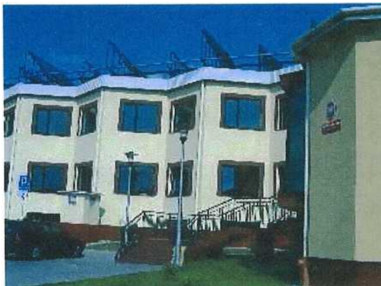
Ryc. 8. Kolektory słoneczne na Pływalni Miejskiej
