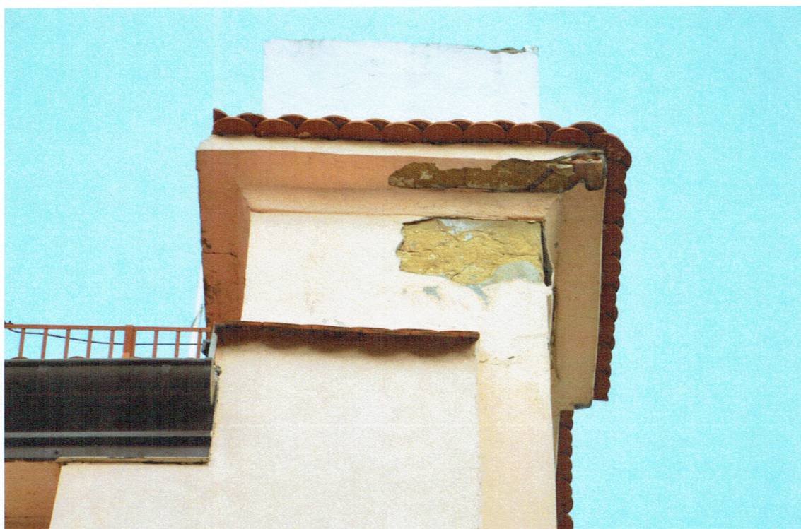
Fot. 19. Fragment elewacji południowej – widoczne ubytki tynku z ostatniego remontu
