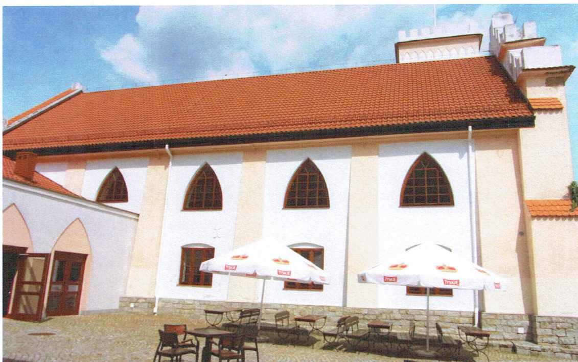
Fot. 44. Elewacja południowa
