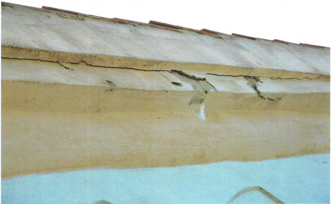
Fot. 64. Fragment elewacji zachodniej - widoczne gzymsu szczytowego
